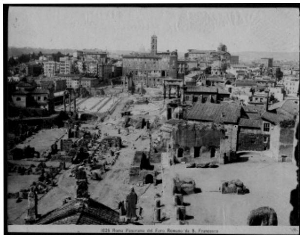
L'area del Foro Romano ripresa dalla chiesa di Santa Francesca Romana, fine del XIX secolo: visibile a sinistra, in alto, la chiesa seicentesca di Santa Maria Liberatrice, che Giacomo Boni fece demolire nel 1900 per poter scoprire l'antica chiesa di Santa Maria Antiqua, nota dalle fonti, invano cercata da Rodolfo Lanciani.
