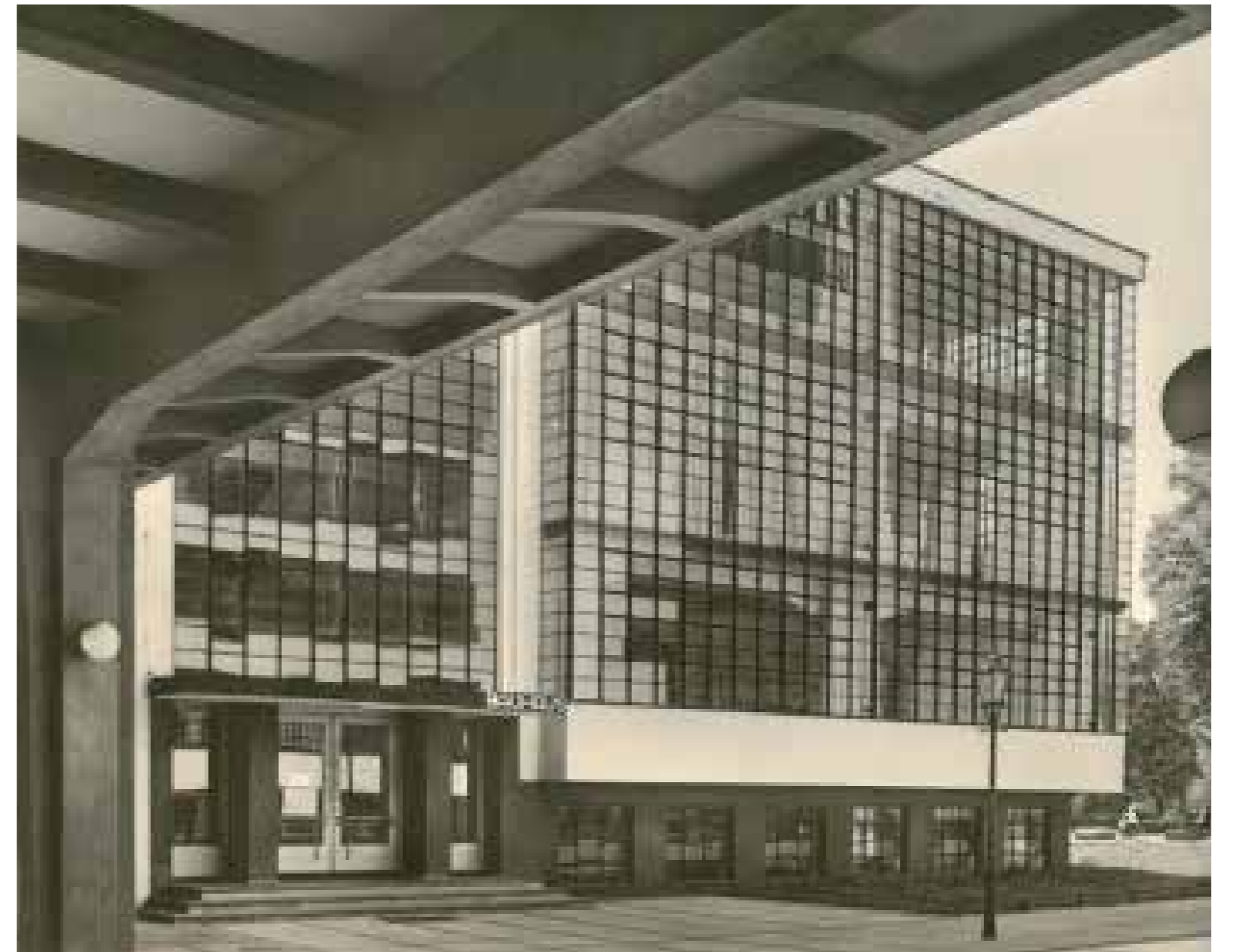
sopra Veduta della facciata settentrionale e dell'ingresso dei laboratori del Bauhaus a Dessau, completati nel 1926 su progetto di Walter Gropius.
